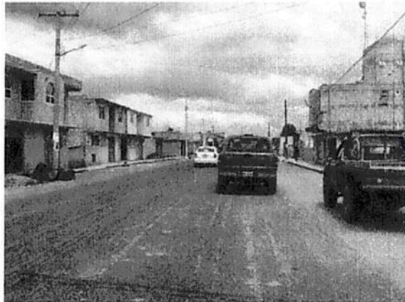
Carpeta asfáltica con desgaste, grietas, derrumbes, sin señalamiento horizontal ni vertical iii) Del km 2+400 al km 2+998.77 sentido a Concepción de los Baños (calle pavimento)
