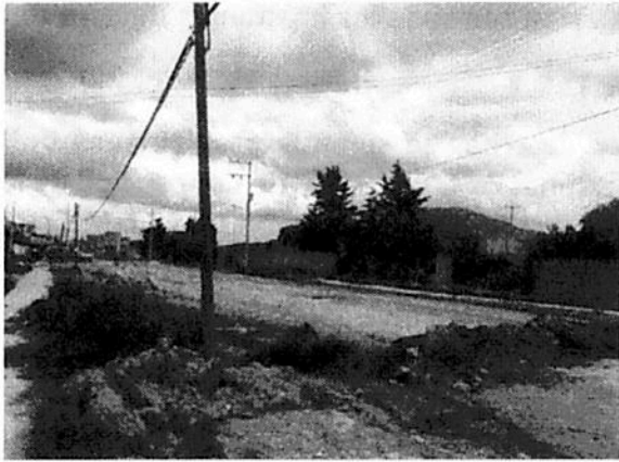
Tramo en terracería revestida Cadenamiento 2: sobre Calle Emiliano Zapata Del km 1+500 al km 2+550 sentido a Concepción de los Baños
